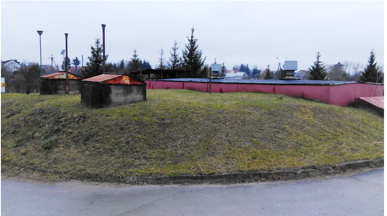
Widok od strony południowej
